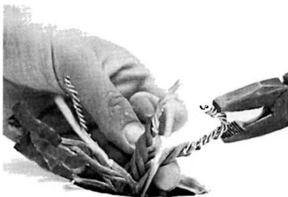
Рис. 2.91. Скрученные провода в месте установки разветвительной коробки
