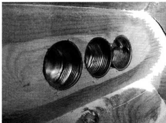
Рис. 2.110. Металлические монтажные коробки для розеток и выключателей
