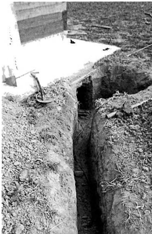
Рис. 2.108. Траншея для прокладки кабеля
