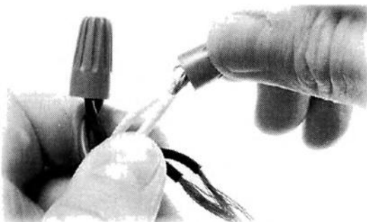
Рис. 2.20. Изоляция колпачком
